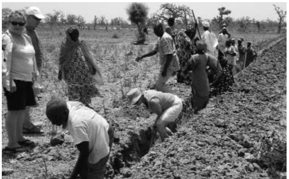
Wasser für 20'000 Menschen: mit Pickel und Schaufel und in gleissender Hitze wird ein 1,3 Kilometer langer Graben ausgehoben, der dann das kostbare Nass bis ins Dorf bringt
